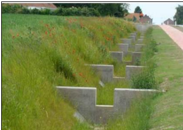
Figuur 69: Gracht met stuwconstructies (Vlaamse Overheid, 2010)
