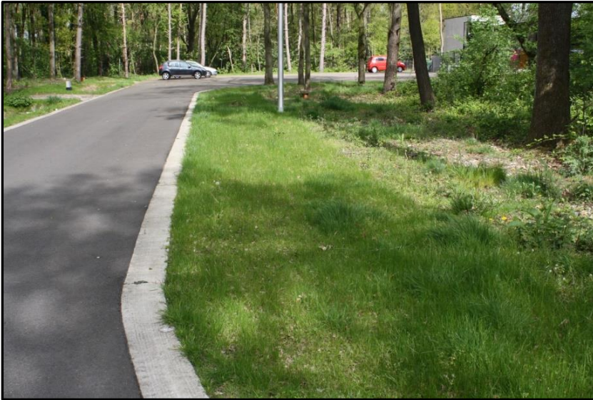
Figuur 64: Voorbeeld waar water van de openbare weg naar infiltratieberm kan afstromen
