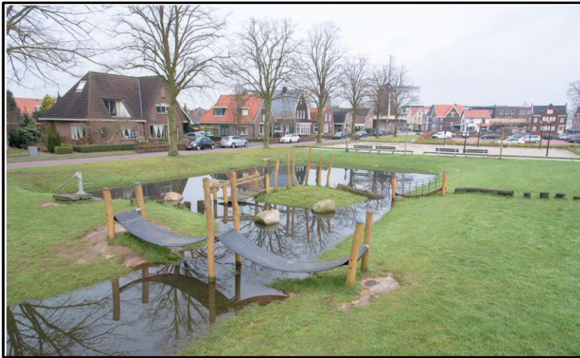
Figuur 81: Multifunctionele inrichting wadi + speeltuinzone (Climatescan, sd)
