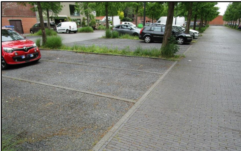
Figuur 80: Centruumparking, deels in waterdoorlatende verharding, 5/06/19
