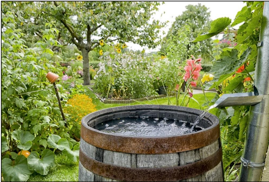
Figuur 63: Regenwaterton voor opvang en hergebruik van regenwater
