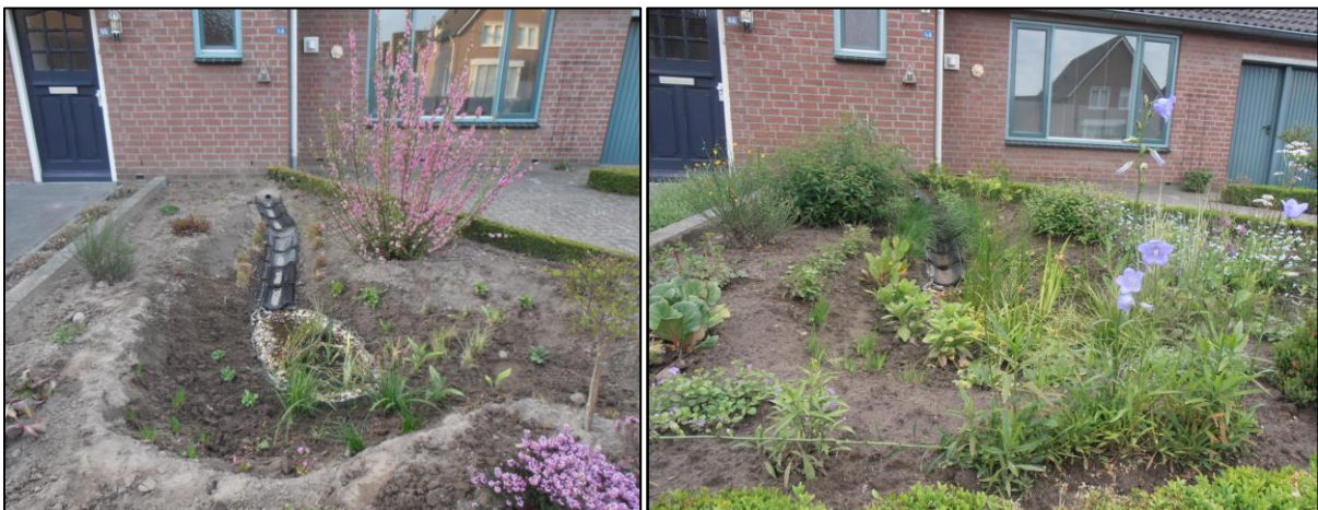
Figuur 61: Regenwater naar wadi in voortuin (links: aanleg wadi, rechts: wadi voltooid) (Van Eck, G., sd)
