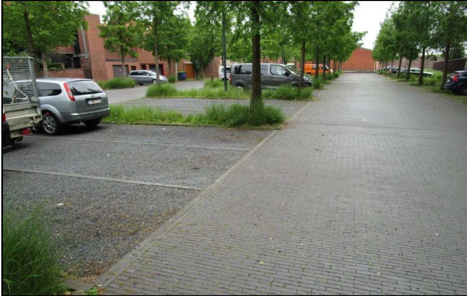
Figuur 75: Voorbeeld waterdoorlatende verharding, centrumparking Ingelmunster
