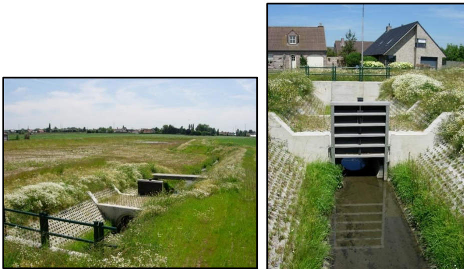
Figuur 29: Stuwconstructie bufferbekken Lendeledebeek
