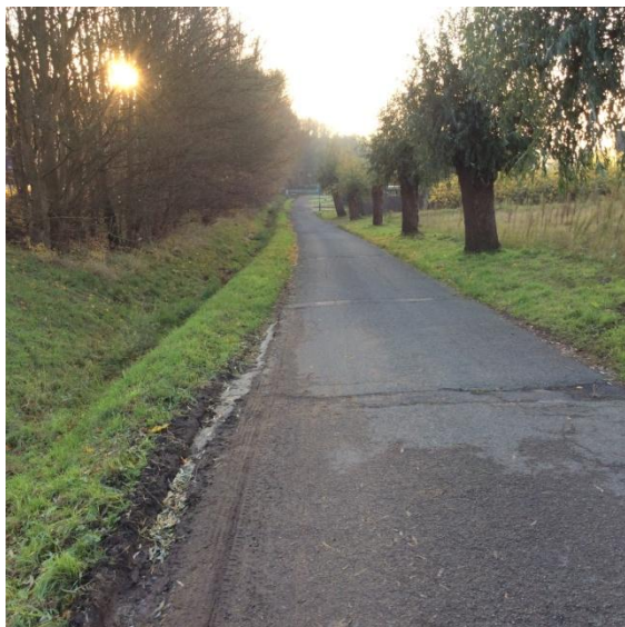
1. Mandelstraat/aanzet berm Ringbrug
