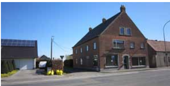
foto 4 - N50d Bruggestraat x Bruggestraat
